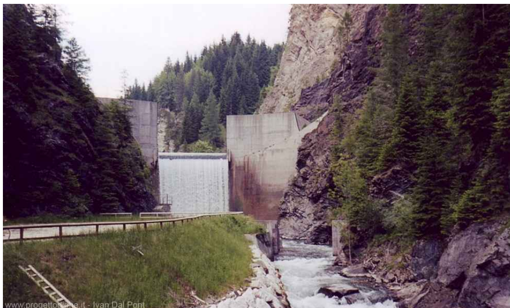
Il corpo della diga con la cascata generata dal salto d' acqua. Foto di Ivan dal Pont. Fonte: http://www.progettodighe.it/reale/caprile.html
